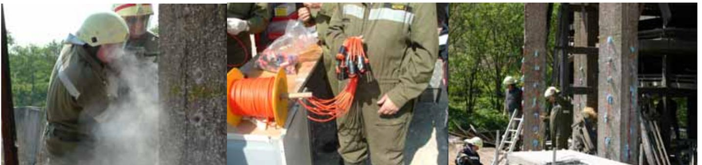
Die von den zahlreich anwesenden Sprengbefugten vorbereiteten Sprengladungen wurden unter der strengen Aufsicht des Einsatzleiters in die Bohrlöcher eingebracht. Um das Besetzen (auffüllen der geladenen Bohrlöcher) zu beschleunigen bzw. den Explosionsdruck optimal zu nützen, wurde erstmals in der Sprenggruppe 04 Brunnenschaum verwendet.
